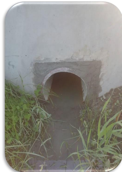
Прочистка трубопересечек
