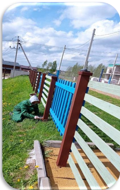
Ремонт детской площадки
