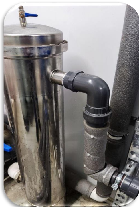
Произвели ремонт на станции водоснабжения
