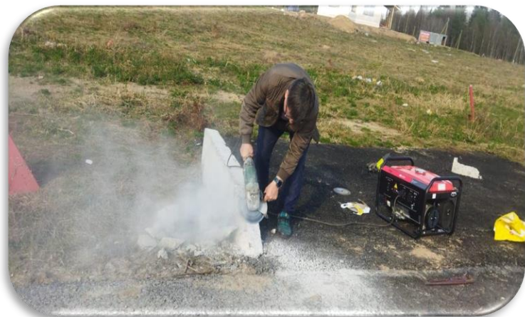
Ремонт бетонных оголовков на въездах
